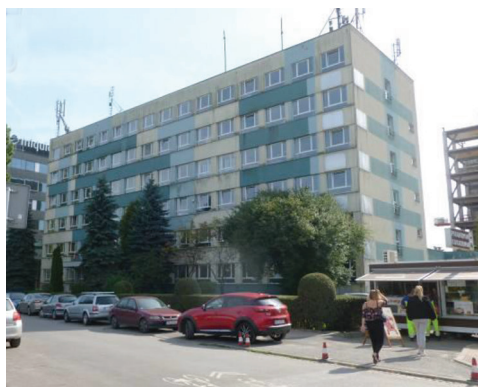
Fot. 13. Budynek OBR MHiR – stan aktualny. [1]
