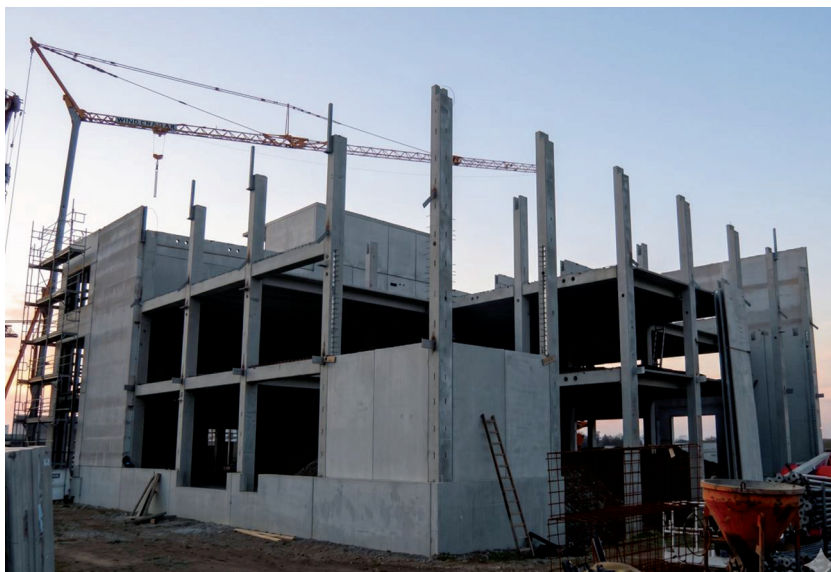
Rys. 3. Kolumny żelbetowe wykorzystane jako naturalne przewody odprowadzające
