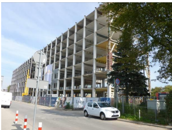
Fot. 21 Dawny budynek Wydziału Potencjometrów aktualnie przebudowywany na akademik. [9]
