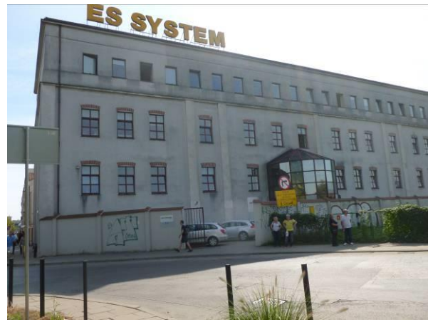
Fot. 24 Siedziba firmy ES-SYSTEM przy ul. Przemysłowej 2. [9]
