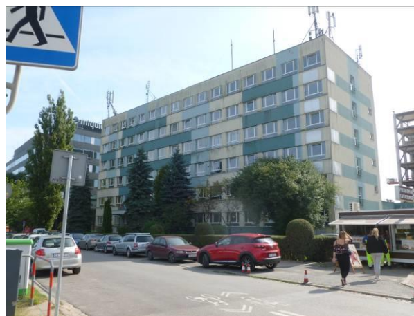
Fot. 22 Budynek OBR MHiR – stan aktualny. [9]
