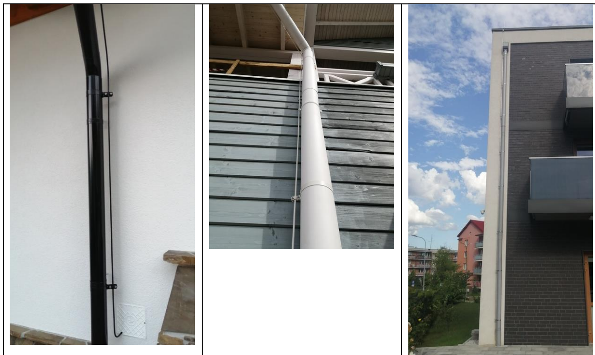
Fot.6. Prowadzenie przewodu odprowadzającego po rurze spustowej
