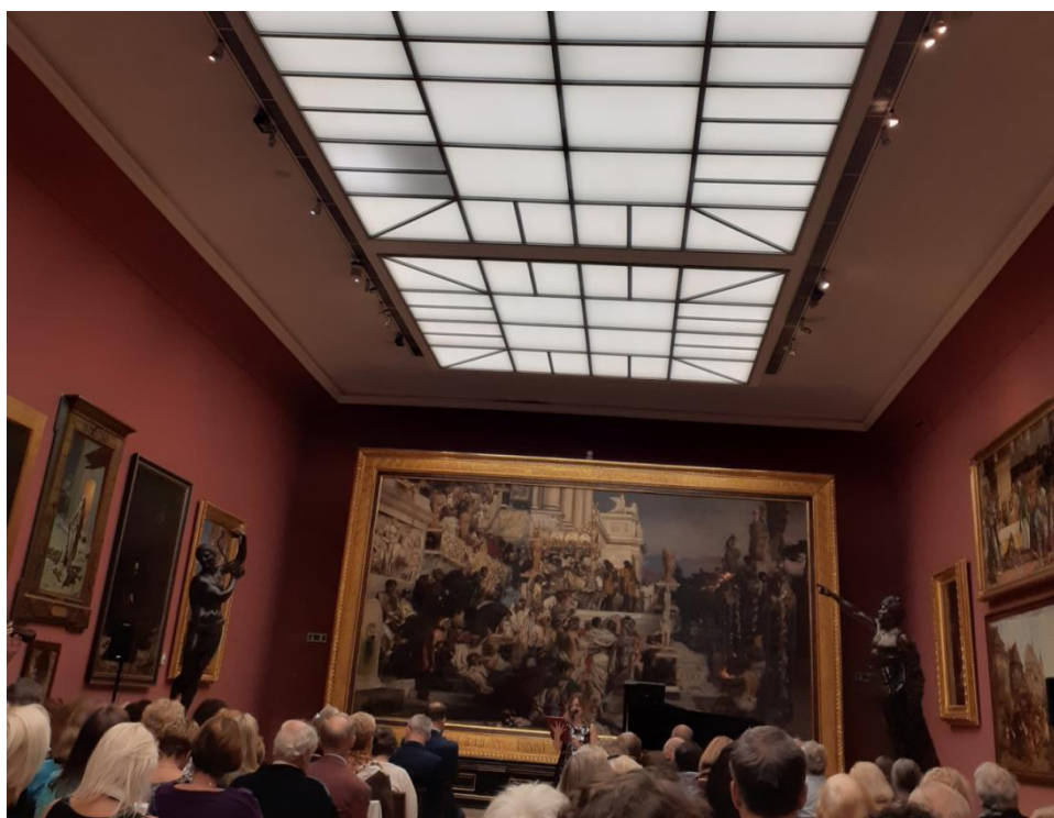
Sala muzeum w Sukiennicach w Krakowie z wyraźnie nierównomiernym oświetleniem sufitu (oświetlenie zrealizowano z wykorzystaniem świetlówek, a nierównomierność można zlikwidować stosując panele OLED).
