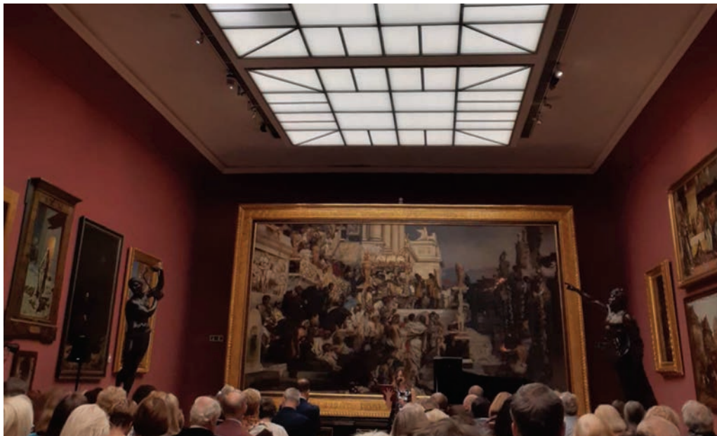
Fot. 1. Sala muzeum w Sukiennicach w Krakowie z wyraźnie nierównomiernym oświetleniem sufitu (oświetlenie zrealizowano z wykorzystaniem świetlówek, a nierównomierność można zlikwidować stosując panele OLED).
