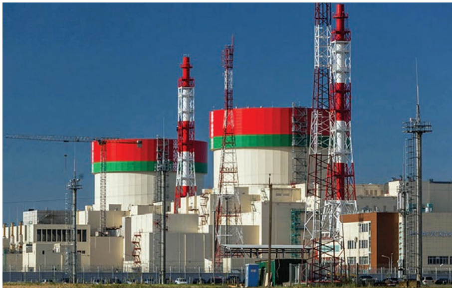
Rys. 4. Ukończone budynki reaktorowe obu bloków zostały udekorowane okładziną w oficjalnych barwach narodowych Republiki Białorusi [fot. Białoruska Elektrownia Jądrowa].
