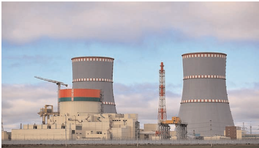
Rys. 3. Najwyższymi budowlami elektrowni w Ostrowcu są dwie potężne chłodnie kominowe współpracujące z układami skraplaczy obiegu wtórnego. Obieg chłodzenia jest zamknięty a wodę uzupełniającą ubytki pobierać się będzie z pobliskiej rzeki Wilji [fot. Rosatom].
